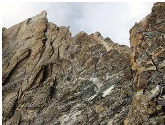
Sun Patch Spur下部岩壁の最上部はボロボロの岩
